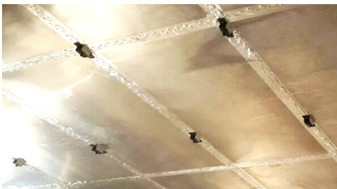
شکل ۲-۲: نمونه دستک های U شکل جهت اتصال تجهیزات به سقف
